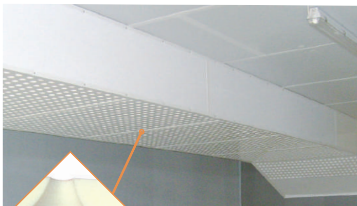
Конусовидні фрезеровані отвори для рівномірного та енергоефективного відведення повітря.
