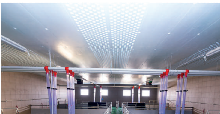
Конусовидні фрезеровані отвори для рівномірного та енергоефективного відведення повітря.
